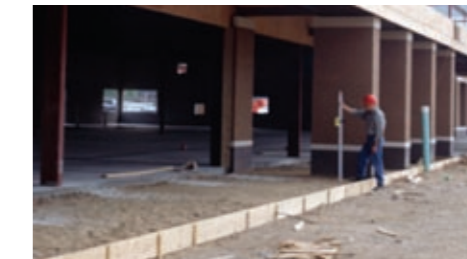
Schalungen und Fundamente
